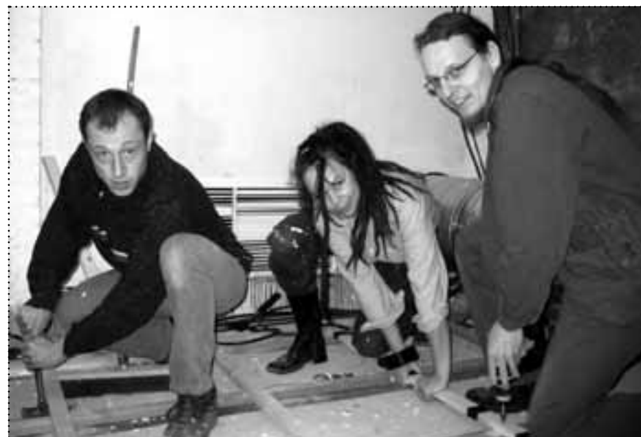
Bei den Umbauarbeiten im Keller des OstEnd-Theaters legen die Macher Christina Emig-Krönning (mitte) und Hans-Henning Raven (links) sowie Akustiker Kay Vogt (rechts) selbst Hand an.
